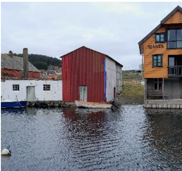
Figur 42. Nottørke på gnr. 26, bnr. 8 (bygget med rød fasade)
