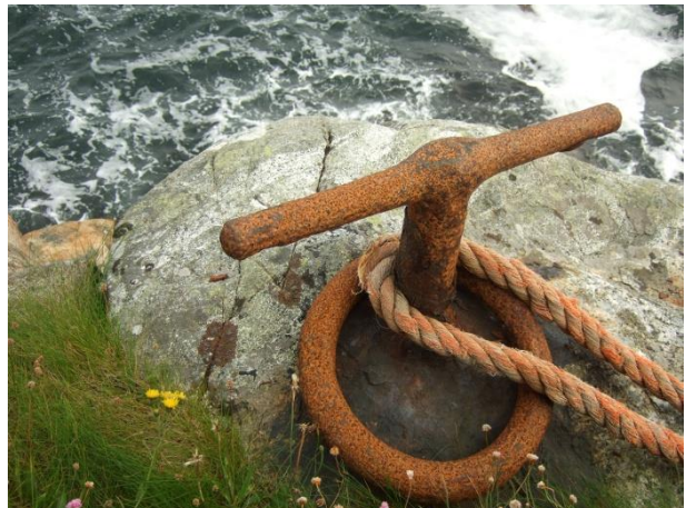
Figur 37. Landnotbolt i Kvalvikvågen.
