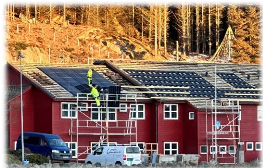
Solceller installeres på Siratun mars 2023
